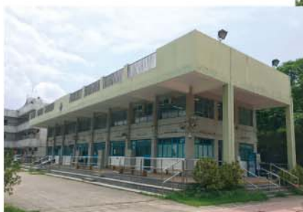
大潭童軍中心綜合樓宇設施改善工程
