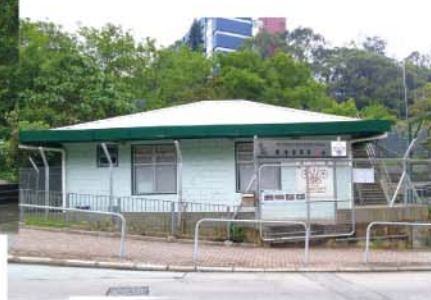
港島第七旅旅部樓宇維修工程
