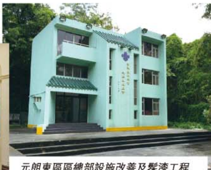
元朗東區區總部設施改善及髹漆工程
