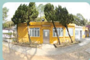
洞梓童軍中心更新鐵窗工程
