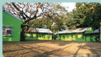
蔡志明聯光童軍中心樓宇設施髹漆工程
