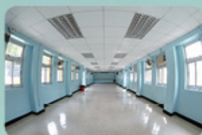
洞梓童軍中心丁神父堂天面及內部翻新工程
