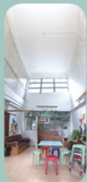
大潭童軍中心 行政大樓天花維修
