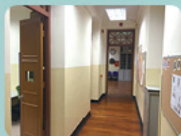
港島西區區總部髹漆工程
