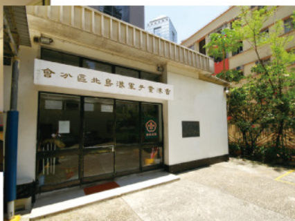
港島北區區總部
