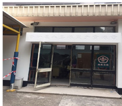
港島北區區總部樓宇維修工程
