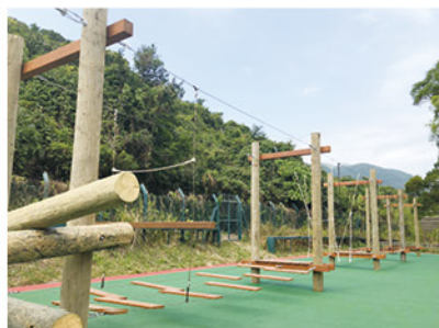
大潭童軍中心繩網陣改善工程
